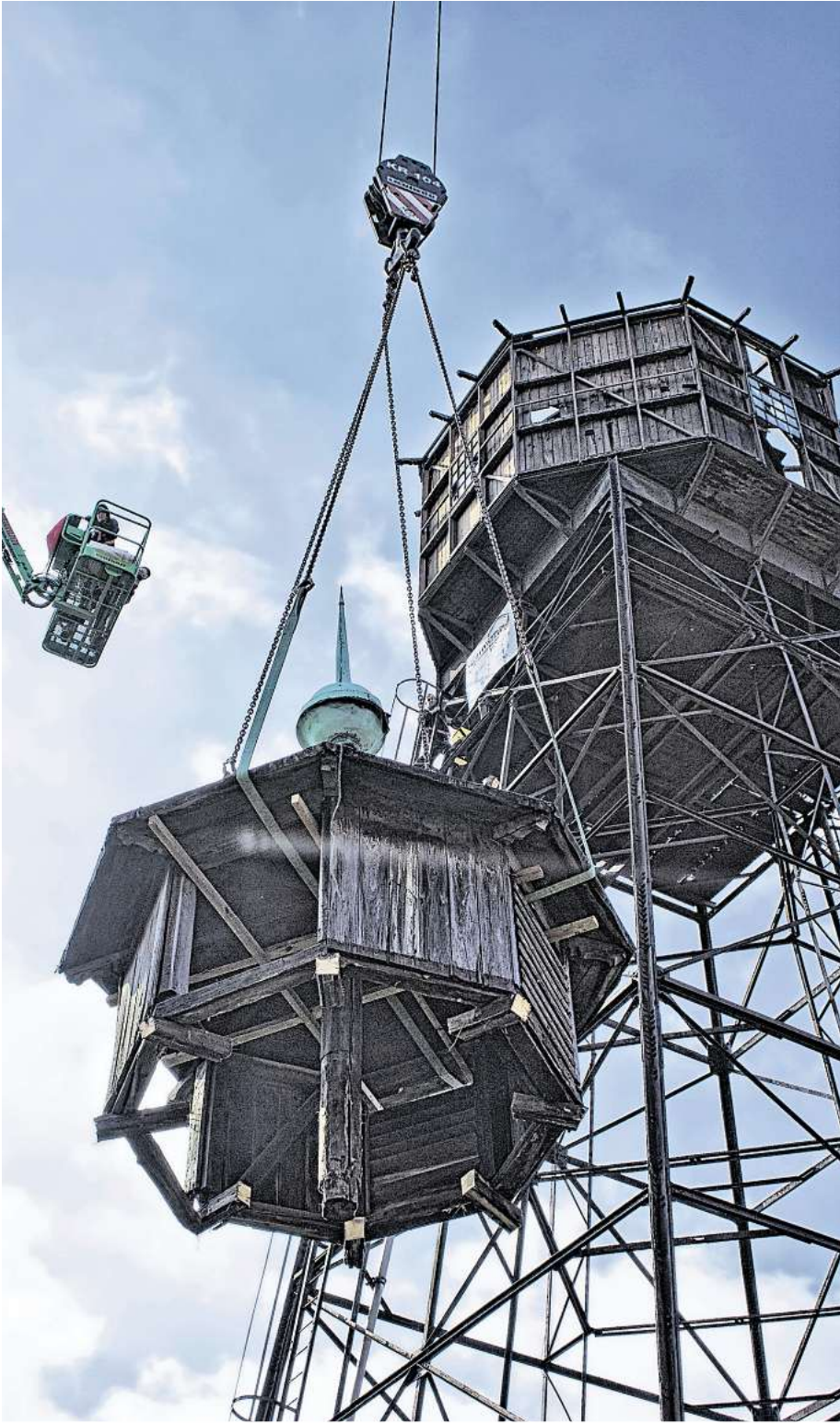
Die 700 Kilogramm schwere Holzkuppel wurde abgesägt und zu Boden geholt (Bild oben). In den angrenzenden Werkstätten des Vereins Bildung und Beruf wird der gesamte Turm saniert. Markus Wiese (unten) kümmert sich um die äußere Holzverkleidung.
